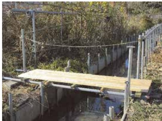
（蓮池の土手補修）
