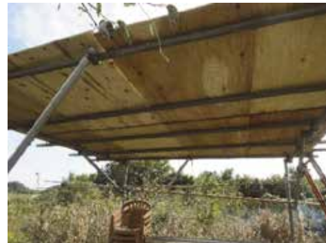
（休憩所の屋根の補修）
