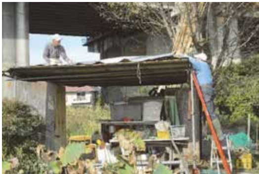
（作業所の屋根の補修）
