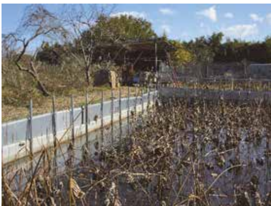
（側溝の橋の架け替え工事）
