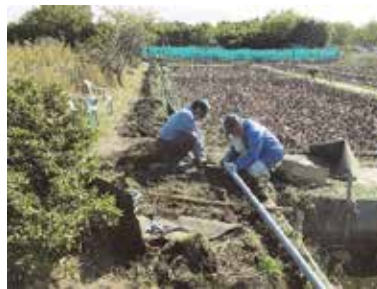
（導水パイプの接続作業）
