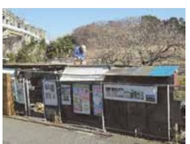
（入口小屋の屋根補修）
