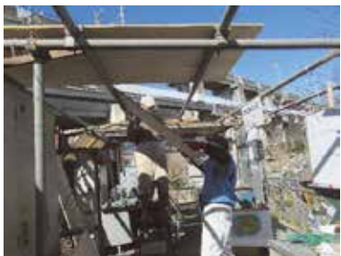
（入口小屋の屋根補修）
