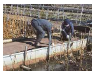
（除草シートの設置）
