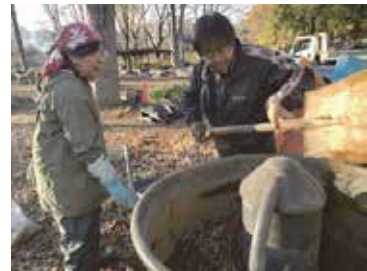
③ 煉瓦造り：コンクリートミキサー使用
