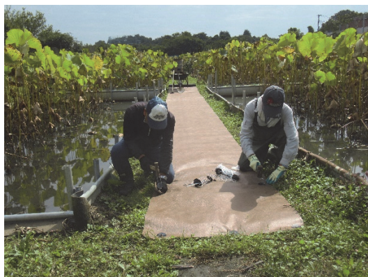
（除草シート敷設作業）
