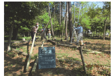
4 月倒木防止支柱の設置作業
