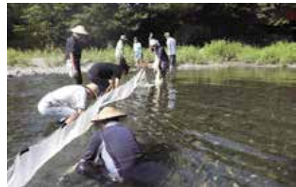
浅間堰での補修作業の様子（2月24日）
