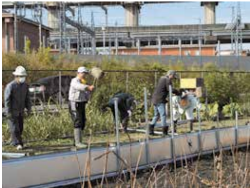
（蓮池の土留め作業）
