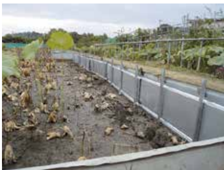
（主遊歩道側の蓮池の土止め）
