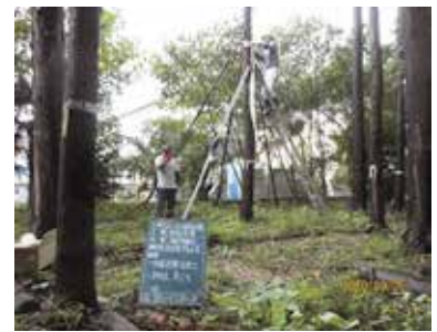
9 月倒木防止対策の支柱工設置風景
