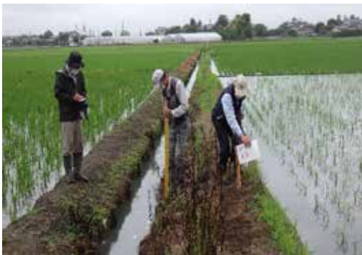
（魚道設置水路水田・測量）
