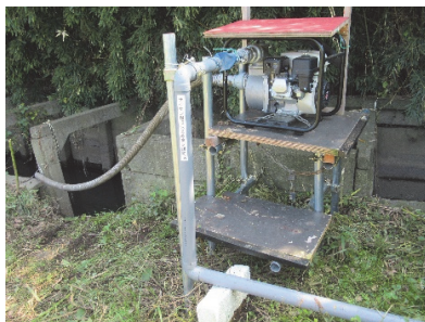
（給水ポンプの設置）
