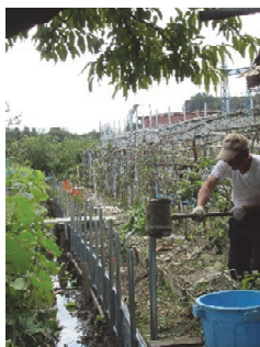
（側溝の土手補修）
