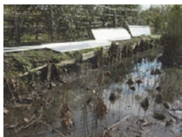
補修前の外池
