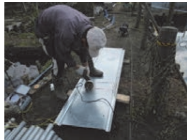
池間の連結パイプ用穴あけ
