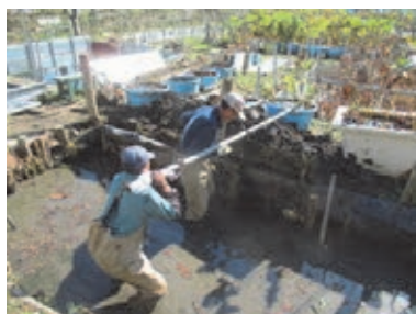
古い木杭の引き抜き除去
