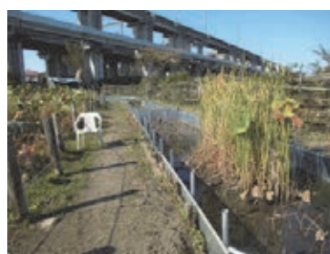
補修後の外池（手前）・睡蓮池
