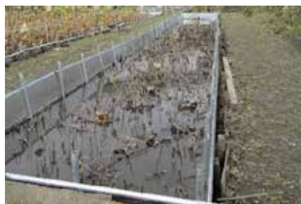
補修後の松池
