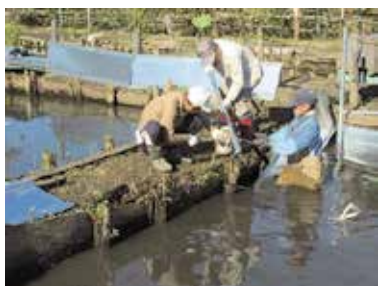
古い木杭の引き抜き除去
