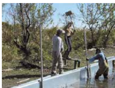
鉄パイプ杭の打込み
