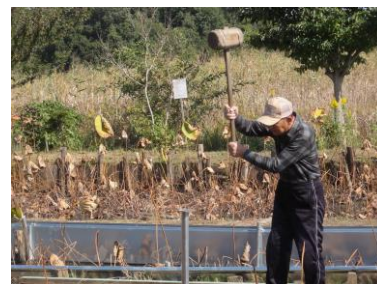
パイプ杭の打込み
