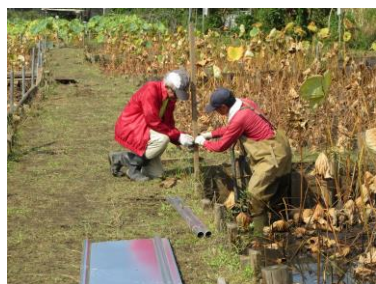
水系による鋼板の設置高さ標示
